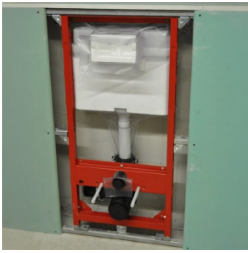
1. WC-MODULIN ASENNUS Asenna asennusteline seinään.
