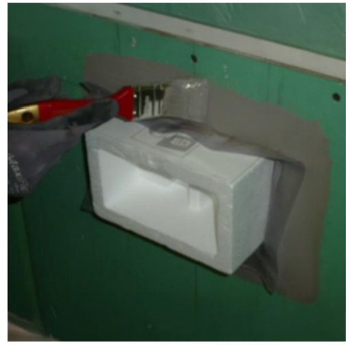
5. VEDENERISTYS HUOLTOLUUKUN ALUEELLA 5A. ENSIMMÄINEN VEDENERISTYSKERROS Levitä vedeneristys huoltoluukun alueelle.
