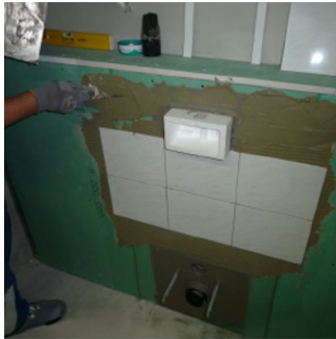
6. LAATOITUS 6A. ENSIMMÄINEN VAIHE Aloita laatoitus.
