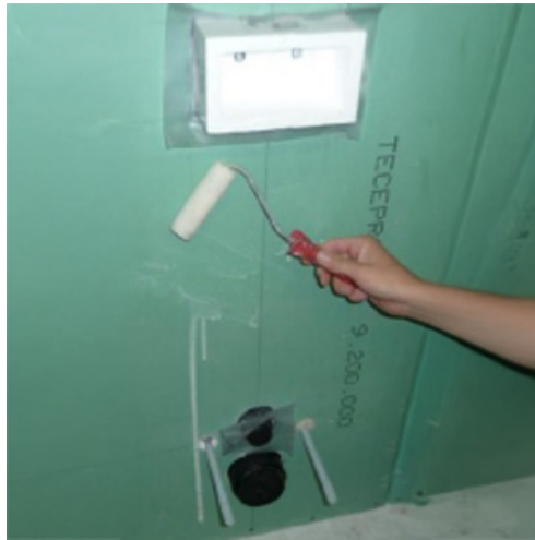
3. VEDENERISTYKSEN VALMISTELU Levitä primeri etulevyyhin.
