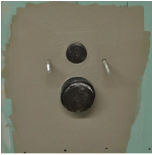
4D. KOLMAS VEDENERISTYSKERROS Levitä kolmas kerros kokonaan huuhtelu- ja viemäriputken ympärille 2,5 tunnin kuluttua.
