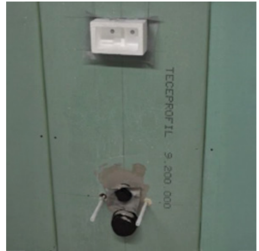
4. VEDENERISTYKSEN LEVITTÄMINEN Levitä vedeneristys oikeisiin kohtiin.
