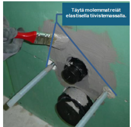
4C. TOINEN VEDENERISTYSKERROS Levitä toinen kerros heti laipan kiinnittämisen jälkeen.
