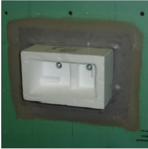
5B. LAIPAN ASENTAMINEN Paina laippa kosteaan vedeneristykseen ja tasoi erityisesti sisäreunasta.
