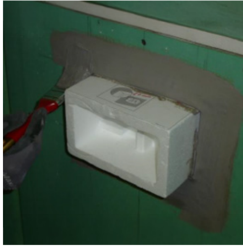
5C. TOINEN VEDENERISTYSKERROS Levitä toinen kerros heti laipan kiinnittämisen jälkeen.
